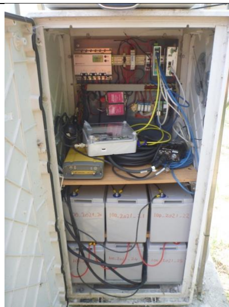
Stazione OL01: installazione del nuovo gruppo di batterie, 300Ah @ 24V (7.2kWh).
