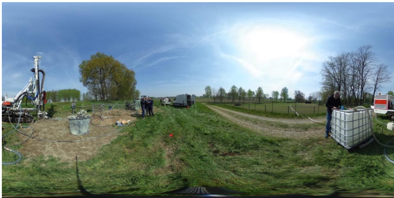
Figura 4. Stazione OL10, in Comune di Cavenago d'Adda (LO). Perforazione a distruzione del nucleo del pozzo di 75m per alloggiare il sensore velocimetrico. A questa operazione fa seguito l'inserimento del rivestimento e la successiva cementazione dell'intercapedine rivestimento-terreno, per garantire l'accoppiamento ottimale dei sensori.
